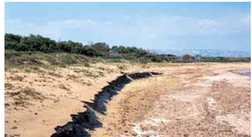
Evidenti segni di erosione in una spiaggia siciliana
