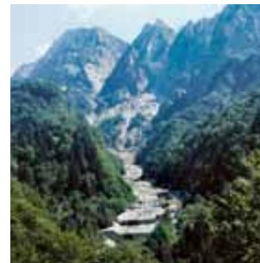
Un torrente montano con gli evidenti segni dell'intervento antropico di risistemazione
