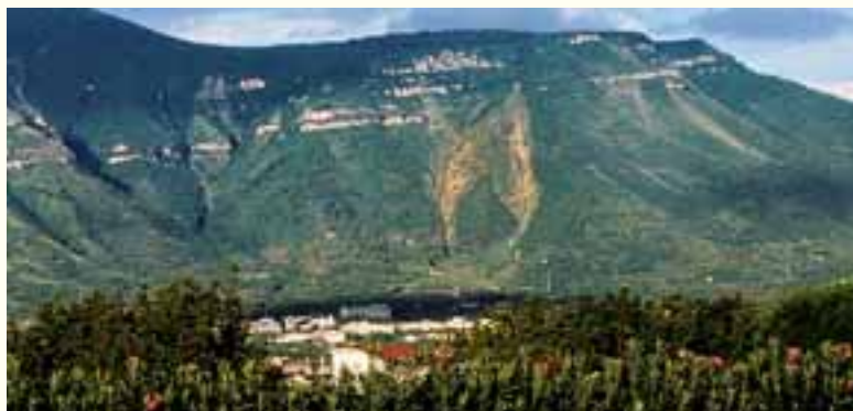
La capacità distruttiva dell'alluvione di Sarno (1998) è stata amplificata dall'enorme quantità di materiale trasportato a valle: dopo alcuni anni e, nonostante gli interventi di risistemazione effettuati, la cicatrice nella montagna è ancora ben visibile
